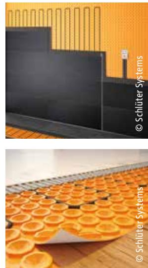
Das Heizwasser wird in einem Kreislauf geführt: Nachdem es seine Wärme auf die beiden Schichten übertragen hat, strömt es gekühlt zurück zum Wärmeerzeuger und von dort wieder erwärmt ins System.
