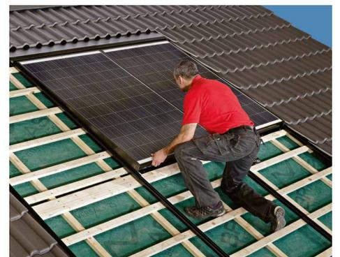
Das BRAAS Indach-System PV Indax ist auf die nahtlose Integration von hochwertigen kristallinen PV-Modulen in Dächer mit den gängigen Dachpfannen ausgelegt. Das System übernimmt die Schutzfunktion der Dachdeckung und produziert umweltfreundlichen Solarstrom – und das als optisch höchst ansprechende Lösung.
