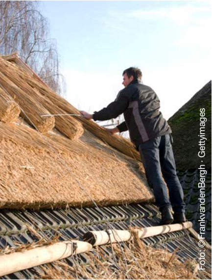
Die Restaurierung von historischen Dächern ist anspruchsvoll und kreativ
